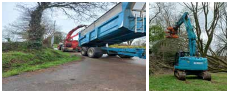
Transformation des branches en copeaux et broyage du bois à St Jean
